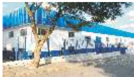
Fábrica 2 Válvulas Seriadas Cajamar - São Paulo - Brasil
