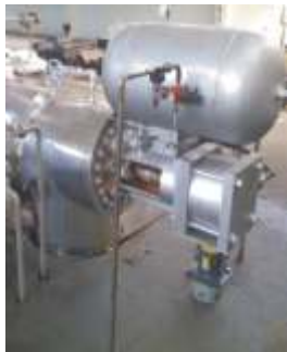
Válvula Globo com Atuador Pneumático para proteção de Turbinas TGM - CITROSUCO
