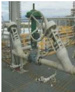
Válvula Globo não Retorno Typo Y Pressure Seal 12" - 2500# RIO POL - LUMMUS SNAM PROGETTI
