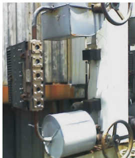
Visor de Nível Bicolor para Caldeira - Visibilidade de 12 1/2" - 1500# USINA SANTA ISABEL
