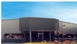
Fábrica 3 Válvulas Especiais Three River - Michigan - USA
