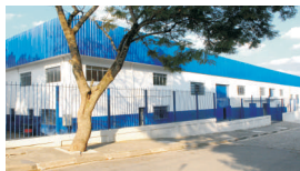
Fábrica 2 Válvulas Seriadas Cajamar - São Paulo - Brasil
