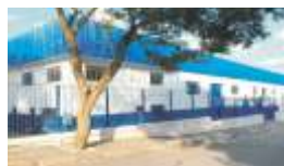
Fábrica 2 Válvulas Seriadas Cajamar - São Paulo - Brasil
