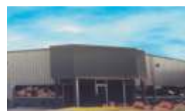
Fábrica 3 Válvulas Especiais Three River - Michigan - USA
