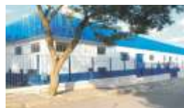
Fábrica 2 Válvulas Seriadas Cajamar - São Paulo - Brasil
