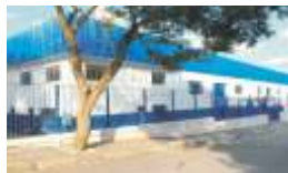
Fábrica 2 Válvulas Seriadas Cajamar - São Paulo - Brasil
