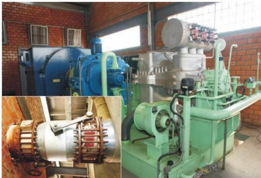
vapor que vaza entre elas. É necessário este conjunto de válvulas pois estas válvula com vedação metal-metal, NÃO são ESTANQUES e somente alcançam vedação classe IV. Esta classe de vedação (IV), permite a passagem de 0,01% da capacidade total.
